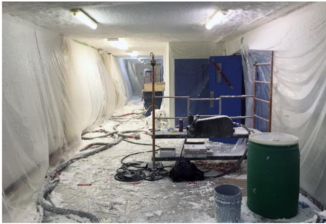
Figure 2: Vue du chantier durant la réalisation du correctif.
