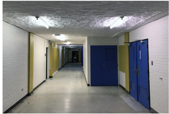
Figure 3: Vue du corridor après les travaux d'amélioration.
